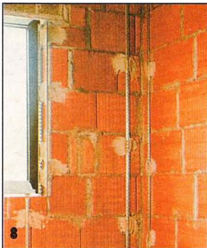
Оштукатуривание внутреннего угла. Отступив 8–10 см от угла, по его обеим сторонам крепят шины-«маяки». Нанесённый между ними раствор выравнивают рейкой-правилом.
