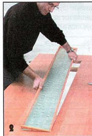
В вырез вставляют рамку из деревянных профилей с закреплённой в ней декоративной филёнкой.
