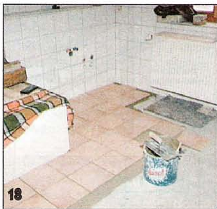
18 На пол плитки укладывали, ориентируясь по линии ванны. Между напольным покрытием и газобетонным каркасом оставили шов, позволяющий потом уложить плитки облицовки самого каркаса.
