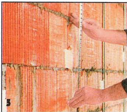
Сначала из трёх «маяков» устанавливают два крайних, затем — средний третий.
