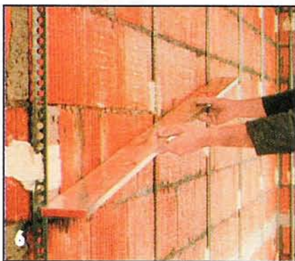
Расстояние между «маяками» должно быть меньше половины длины правила.
