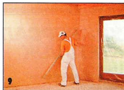
Полностью оштукатурив стену, штукатурку с помощью рейки-правила окончательно выравнивают заподлицо с «маяками».
