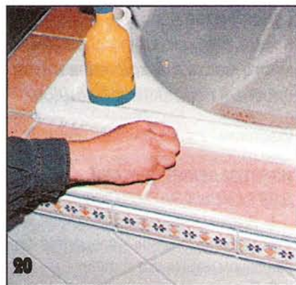
20 Все швы вокруг ванны заделали силиконовым герметиком.
