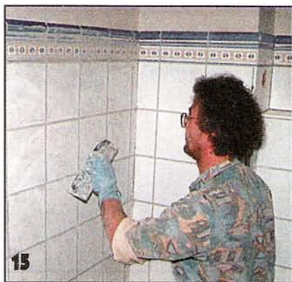
15 Швы затёрли раствором серого цвета. Здесь видно, как проходит бордюр на внутреннем и наружном углах.
