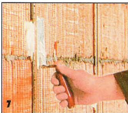
Разравнивая «лепёшки» раствора, проверяют и окончательное положение «маяков».
