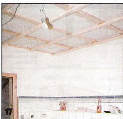
17 К базовым рейкам привинтили несущие, оставляя между обрешёткой и потолком пространство для циркуляции воздуха. Между рейками обрешётки и стенами оставили зазоры.
